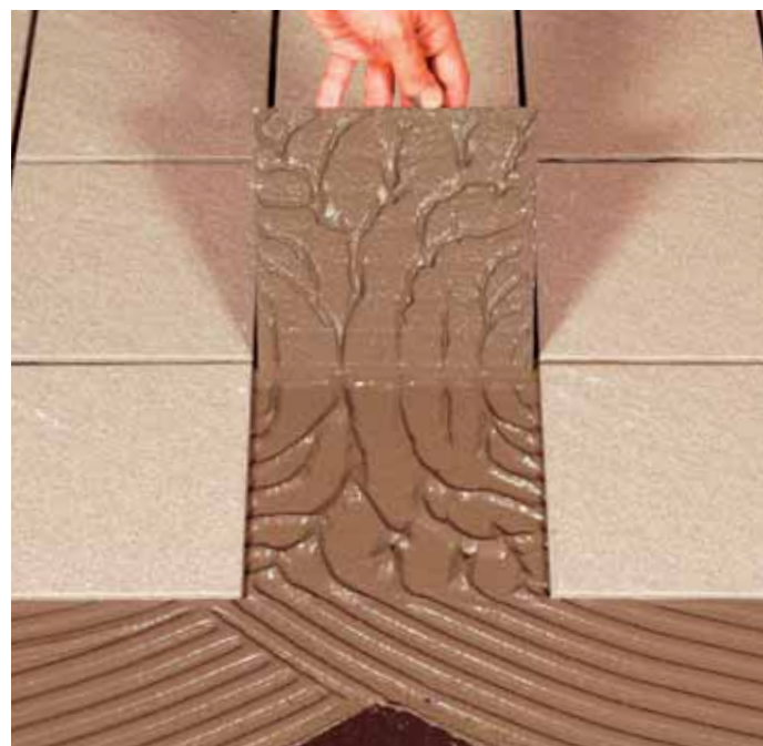
ARDEX X 78 varmistaa alustan ja laatan välille 100 %:n tartunnan. Näin vältetään pakkasvaurioilta.
