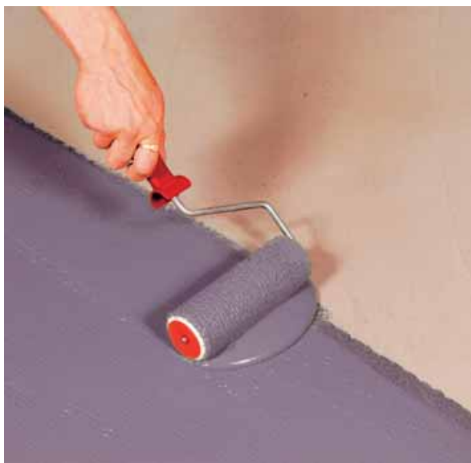
ARDEX 8+9 -vedeneriste telataan alustaan voimakkaasti painaen, jotta saadaan paras mahdollinen tartunta.
