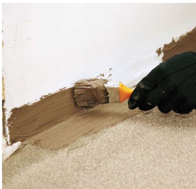
Lattian ja seinän rajakohdat tiivistetään ARDEX EP 2000 -höyrynsulun päälle ARDEX 8+9 -vedeneristeellä ja ARDEX SK 12 -vahvistusnauhalla.
